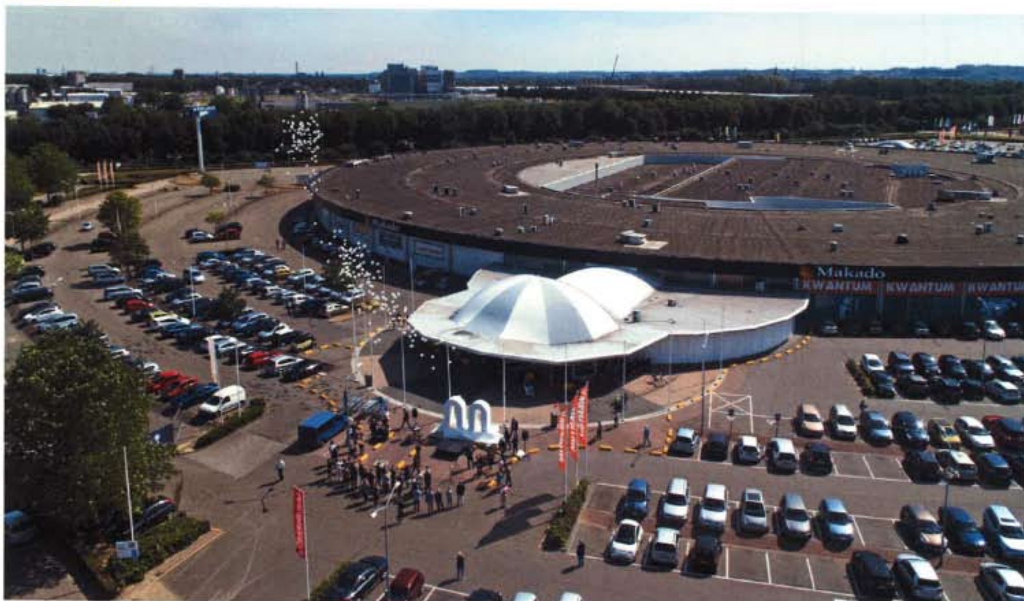
De onthulling van een nieuw logo en ballonnen markeerden gisteren de start van de nieuwbouw en de verbouwing.
